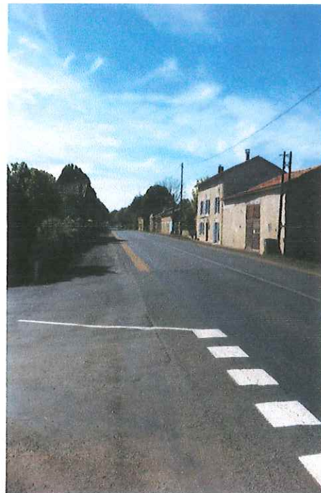
traversée de Chaignepain (entrée Ouest)
